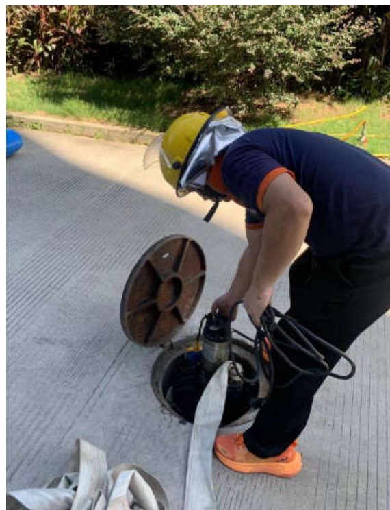
水泵放入雨水口，并接通管道
